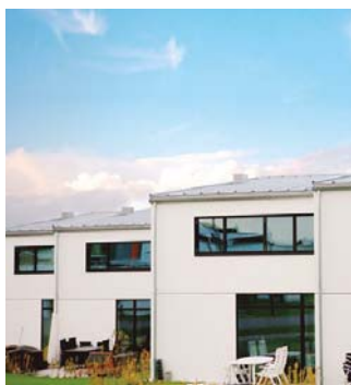
Brabrand Boligforening es un proyecto de construcción de 75 viviendas de bajo consumo energético en Hasselager. AQUAREA
