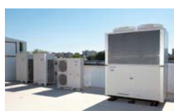
2012 Unidades GHP. Los sistemas VRF de gas de Panasonic son ideales para proyectos en que existen restricciones de potencia.
